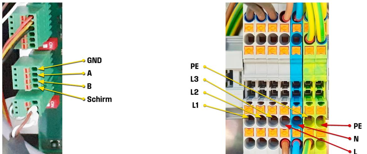
Abb. 16: Elektrischer Anschluss Außeneinheit
