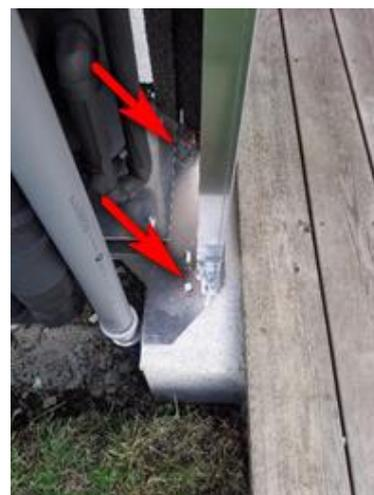
Abbildung 15: Gerät auf Sockel montieren
